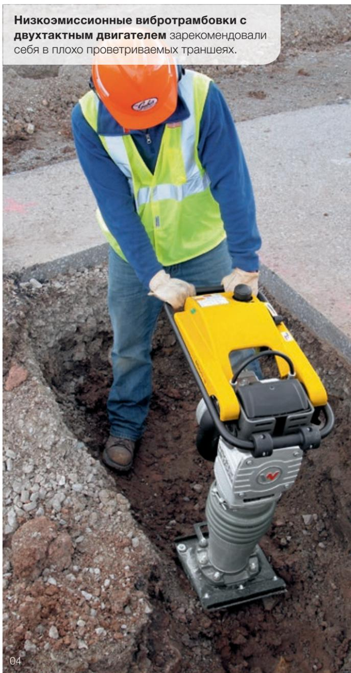
Уплотнение рядом с трубами – с точностью до сантиметра благодаря узкому основанию модели BS30.
