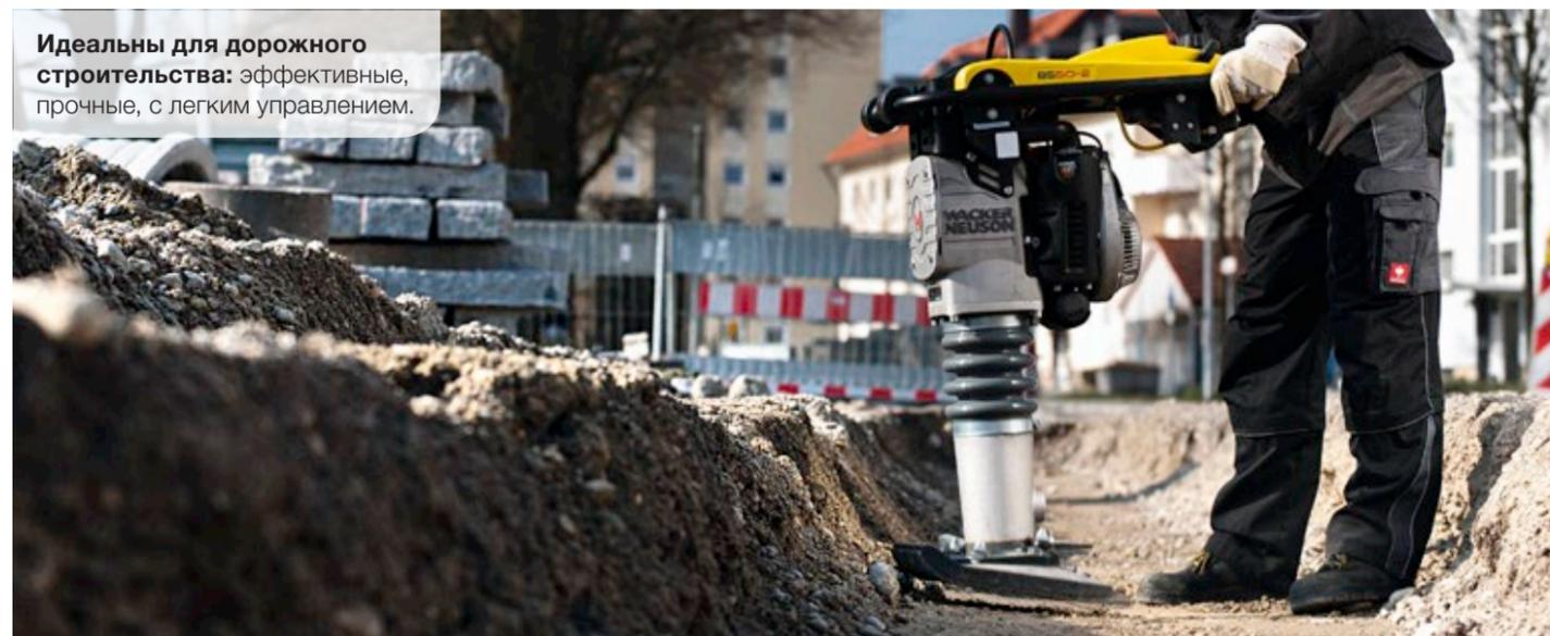
Низкоэмиссионные вибротрамбовки с двухтактным двигателем зарекомендовали себя в плохо проветриваемых траншеях.
